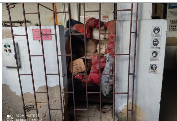
Foto 12. Cuarto de acopio de residuos peligrosos, el cual se encontraba lleno.
